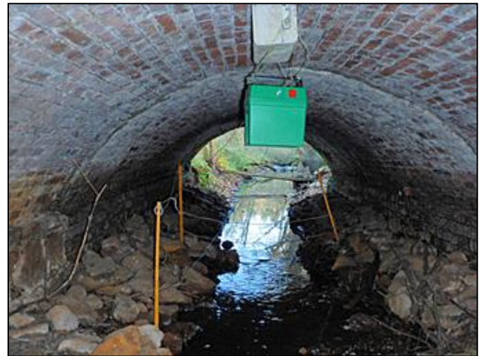
Abb. 3: Zauninstallation (Elektrozaun über Dammbau- stelle, Bermen beidseits frei) 11/2014.
