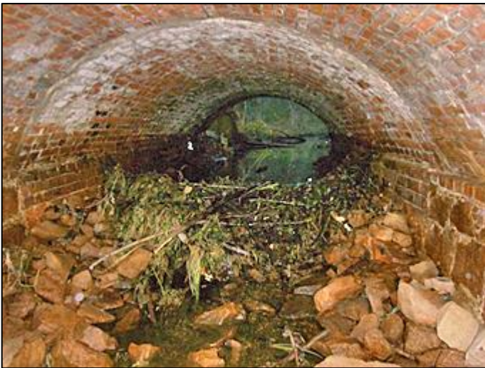
Abb. 2: Dammbau unter Straßenbrücke 12/2015. Foto: C. Otto
