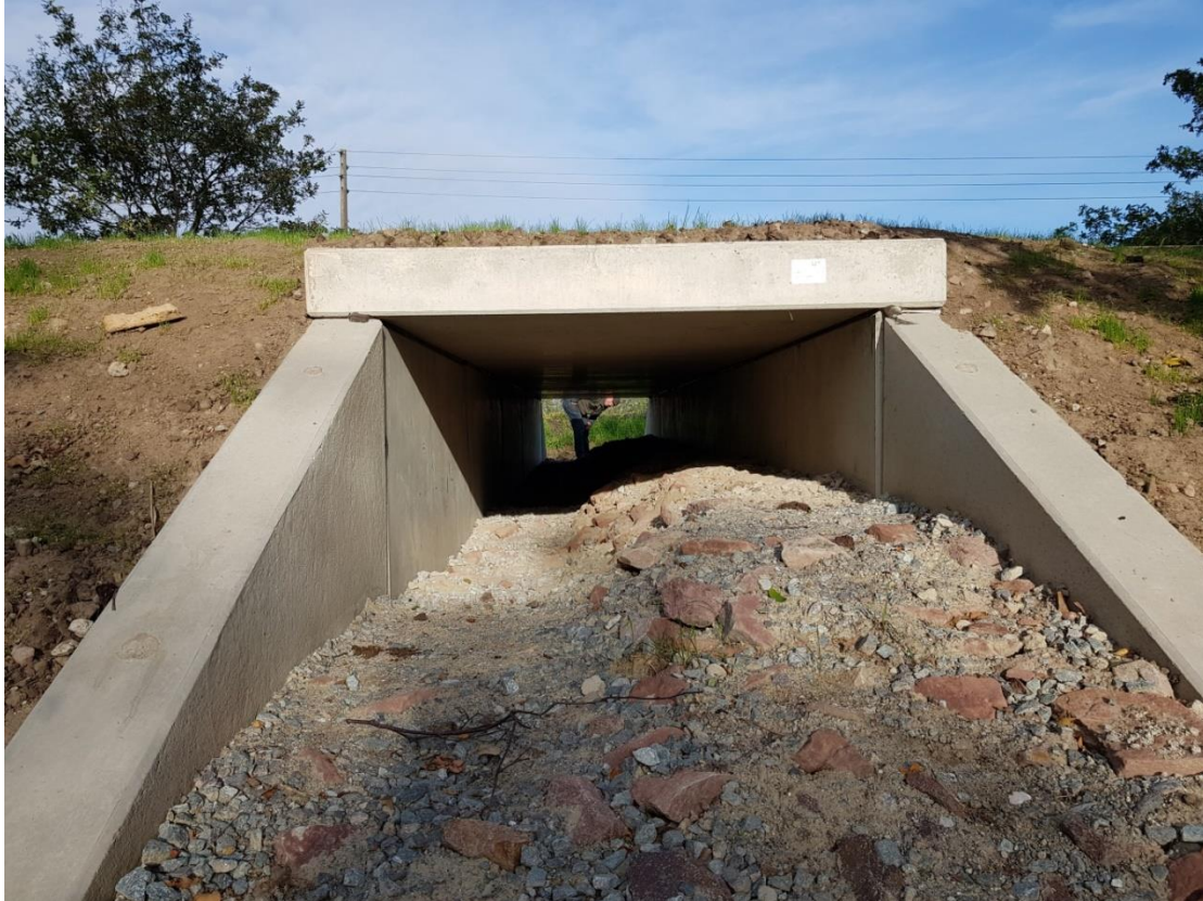
Abb. 1: Neu gebauter Kleintierdurchlass 2 an der L22 bei der ersten Begehung im September 2019 (Foto: J. Weber).
