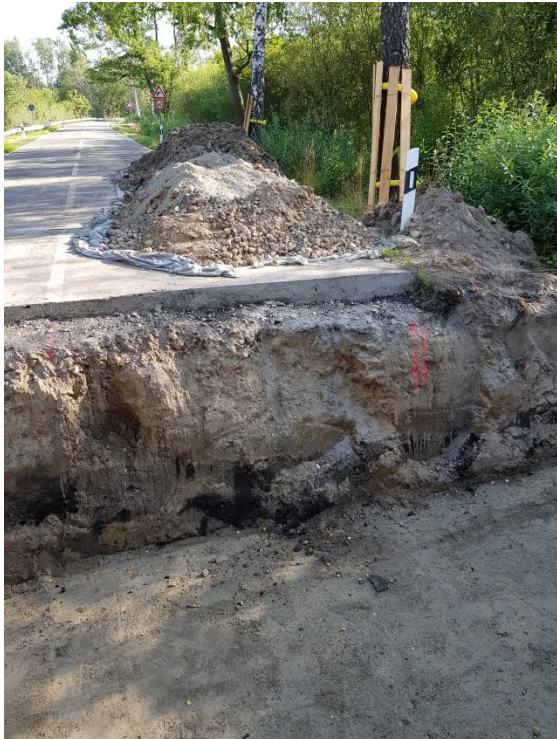
Abb. 1: Öffnung der Straße bei Buchhorst zum Einbau einer Querungshilfe (Foto: A. Weber).
